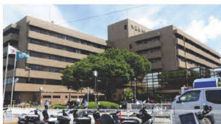
市立伊丹病院(伊丹市昆陽池で)
